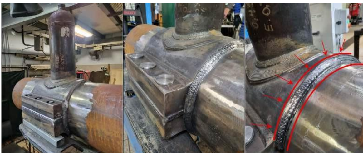
Figura 63 – Exemplo de solda circunferencial para a realização de reparo de abraçadeira sobre duto, com potencial para a utilização do DynaFlex-Arc . Fonte: O autor.
