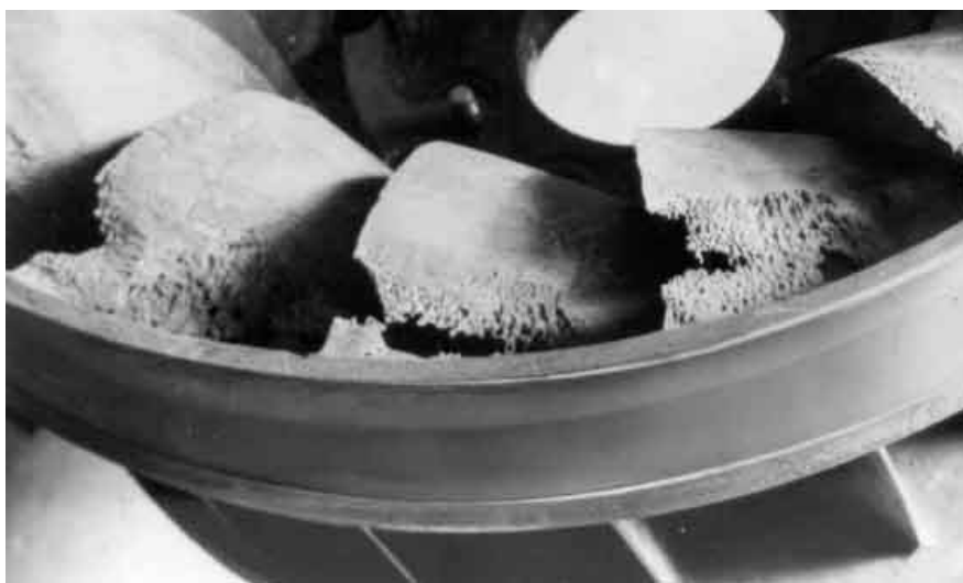
Figura 2.4 - Danos de cavitação em turbina Francis ( http://commons.wikimedia.org 2007).
