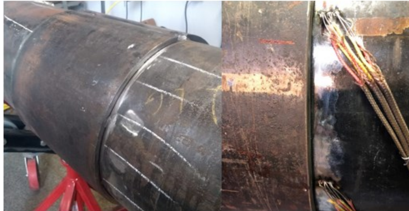
Figura 28. Dupla Calha posicionada sobre o tubo
