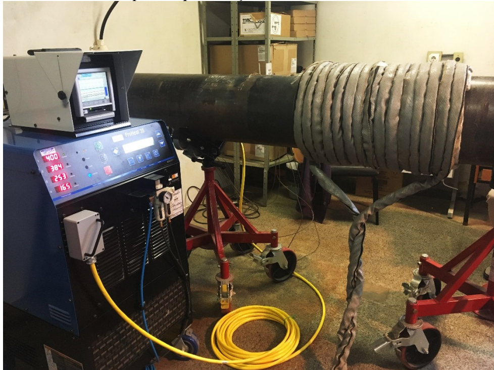
Figura 24. Tubo sendo aquecido por indução utilizando a fonte Miller Pro Heat 35kW
