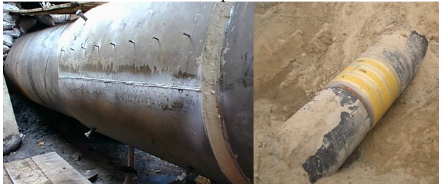
Figura 3. Reparo utilizando calhas e resina epóxi ( grouting ) à esquerda, reparos utilizando invólucro compósito à direita
