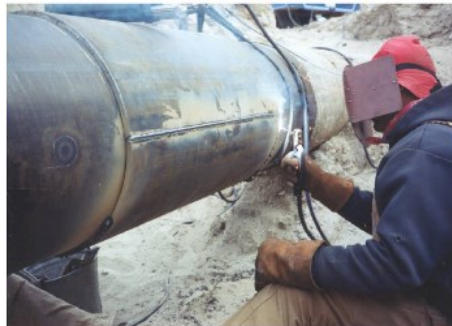
Figura 4. Técnica Dupla-Calha tipo B para reparo de tubulações
