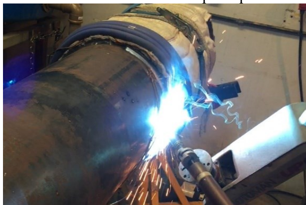
Figura 11. Junta sendo soldada assistida de pré-aquecimento por indução
