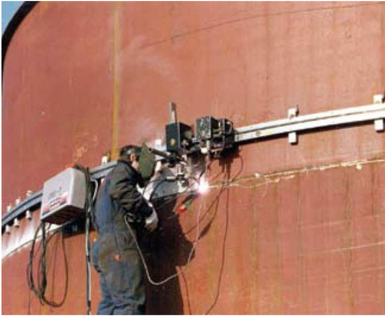
Figura 15 - Soldagem automatizada de costado [18]
