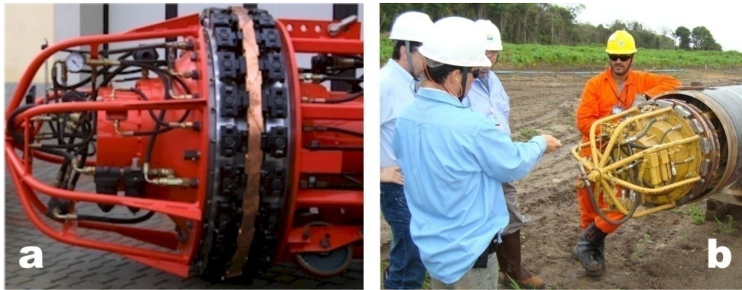
Figura 2-2 – Sistemas para alinhamento de dutos e instalação de backing . Em (a) equipamento da empresa italiana OPUS e em (b) construção de linha dutoviária
