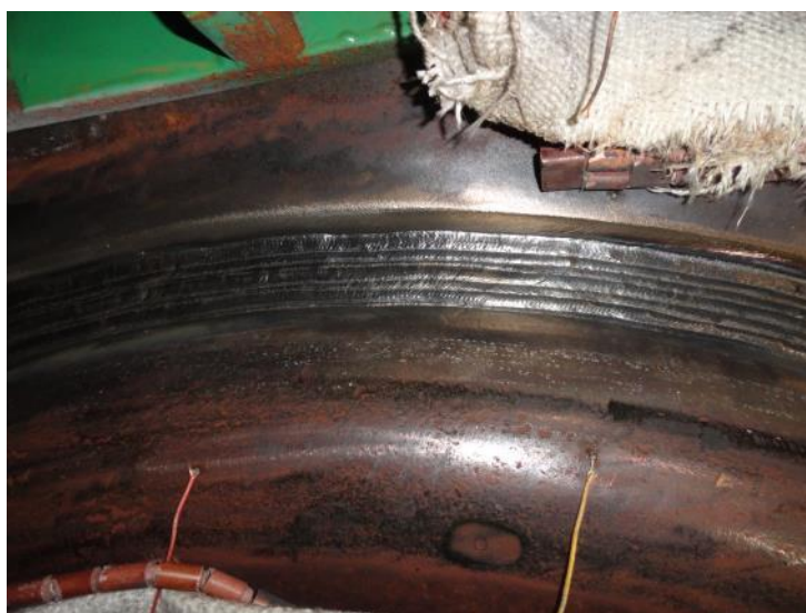
Figura 49. Aspecto superficial dos depósitos de enchimento na soldagem do MCV nas instalações da empresa
