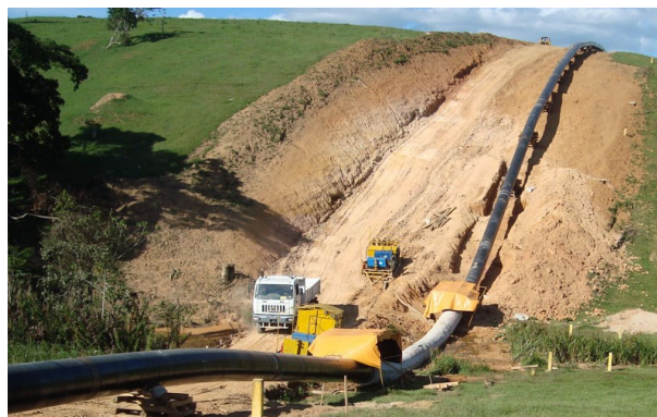
Figura 7: União das seções em campo por meio de soldagem.
