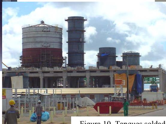
Figura 10. Tanques soldados com o Tartilope V2.
