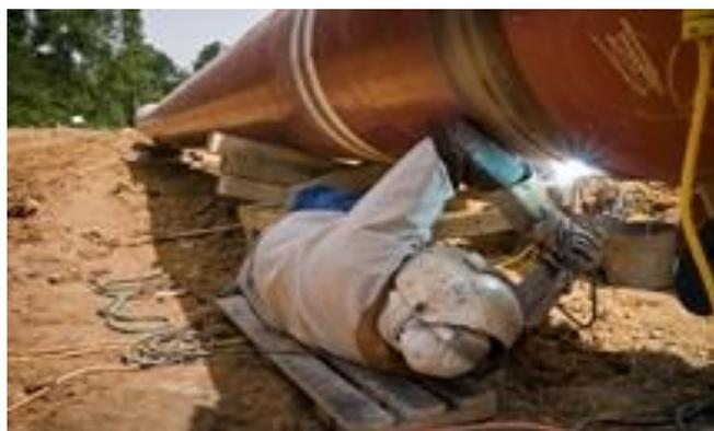
**Figura 1- Soldagem com eletrodo revestido. Nota-se a insalubridade da operação. Fonte: Lincoln Eletric®**
