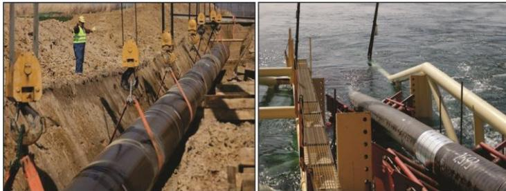
a) **Figura 1 – a) Içamento de duto terrestre [17]; b) Lançamento de duto subaquático [18]**
