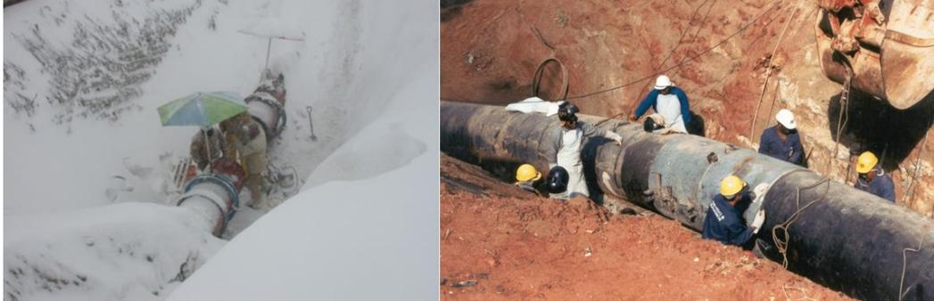
Figura 1. Reparo de dutos em operação em diferentes condições operacionais [25]
