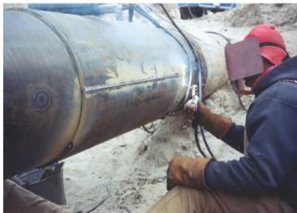
Figura 2. Técnica Dupla-Calha tipo B para reparo de tubulações [25]
