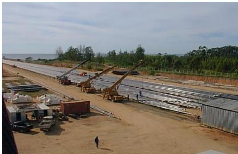
Figura 6 - Racks externos e racks de estocagem dos stalks
