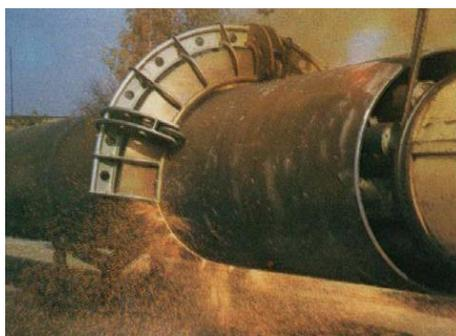
Figura 17 - Soldagem *Flash Butt*
