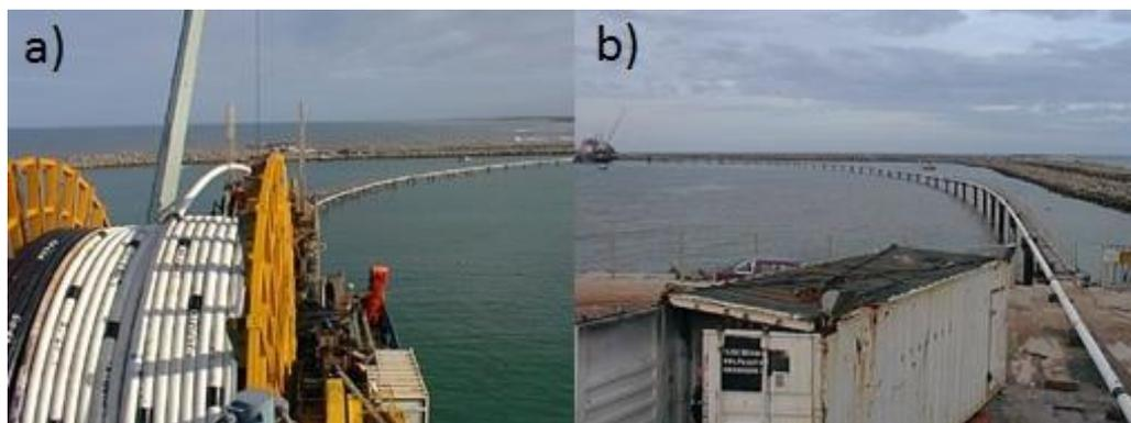
Figura 7 - a) Carretel a bordo do navio de lançamento; b) Estação *tie-in*
