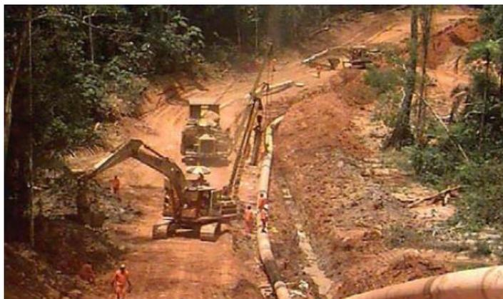
Figura 3 - Abaixamento das colunas
