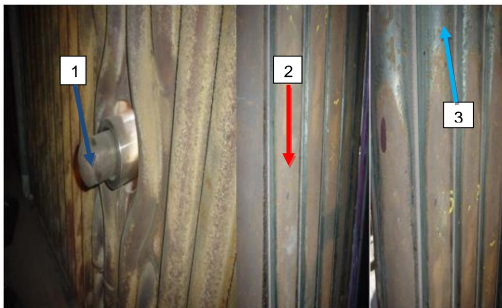
**Figura 4 - Respiro da caldeira (1), tubos afetados pela corrosão (2) e parte do tubo sem corrosão (3)**
