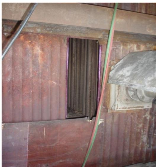
**Figura 1 - Janela de acesso à parte interna da usina**
