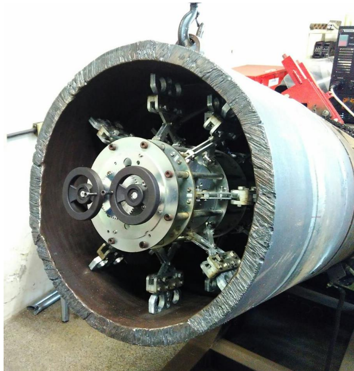
Figura 8 - Sistema sendo aplicado no acoplamento de seções de tubos de 560 mm (22") de diâmetro e 38,1 mm (1.1/2") de espessura.
