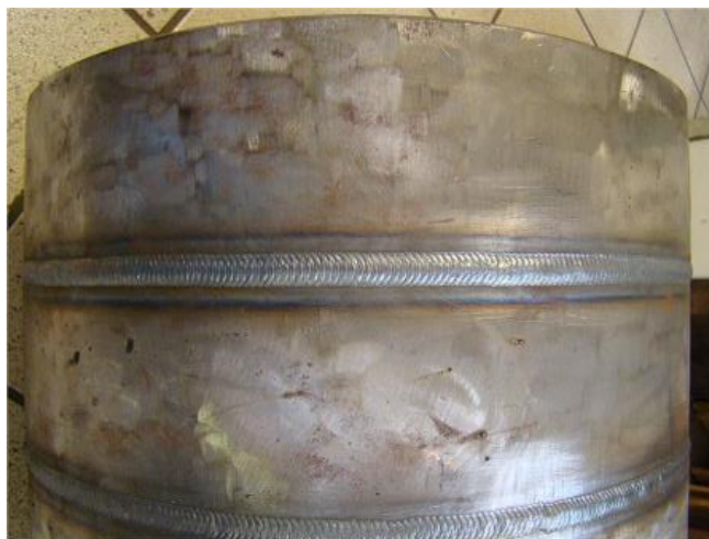
Figura 15. Aspecto visual do último cordão de solda efetuado para o fechamento da junta.
